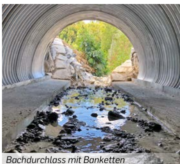
Bachdurchlass mit Banketten
